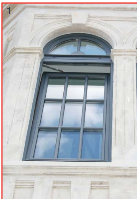
Petits bois : 1- Grilles PB amovibles 2- PB massifs 56x58 3- PB clipsés 2 faces
